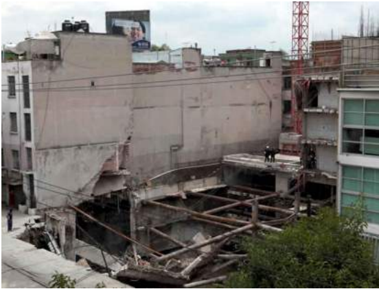
Derrumbe de Zamora núm. 79 (ALM).
